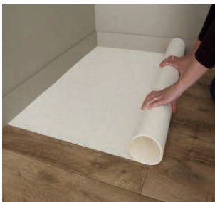
Pose d'une sous-couche de type Tarkoplan sur parquets et laminés « flottants »
